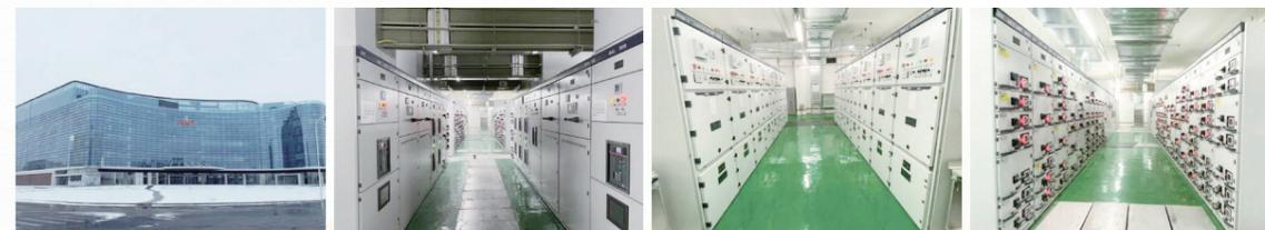
2023年天津澳康达广场项目，是华北地区最大二手车交易市场地标性建筑。百利开关为此项目提供了10kV变电室中的全套电气成套设备，包含变压器6台、10kV开关柜24台、直流屏1台、380V开关柜88台，低压封闭母线槽等产品，全面保障电网安全稳定运行。
